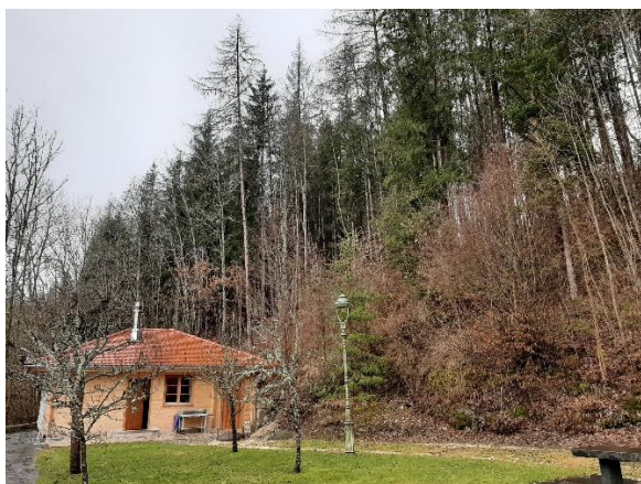
Grundstück Nr. 70/14 inkl. Gebäude mit südlichem Bereich des geplanten Waldumbaus im Hintergrund
