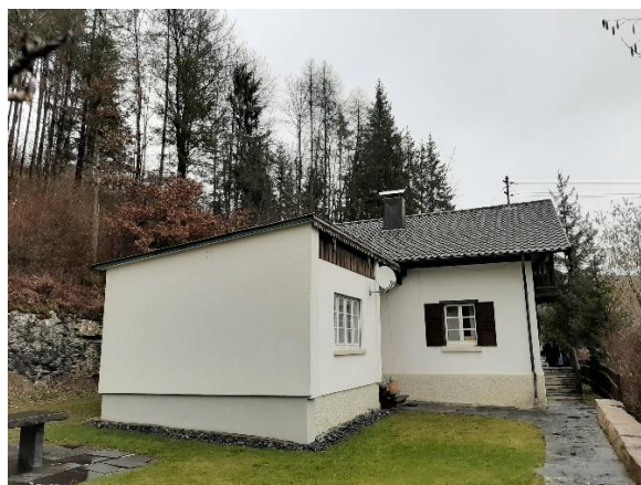
Grundstück Nr. 70/14 inkl. Gebäude mit nördlichem Bereich des geplanten Waldumbaus im Hintergrund
