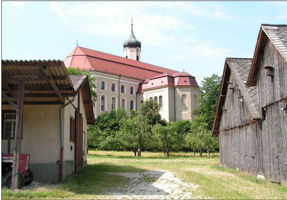
Abb. 20: Blick auf die Klosterkirche zwischen Schuppen und ehem. Stall hindurch (22.07.2020)
