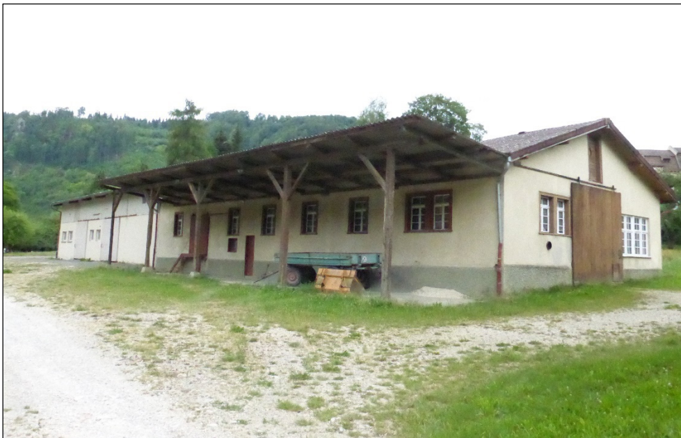
Abb. 13: Ansicht von Gebäude 3 vom Fahrweg aus
