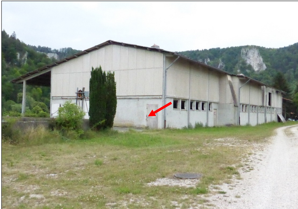
Abb. 14: Ansicht von Gebäude Nr. 4 vom Fahrweg aus. Der rote Pfeil zeigt auf die Türe, in der sich ein Quartier der Zwergfledermaus befindet.
