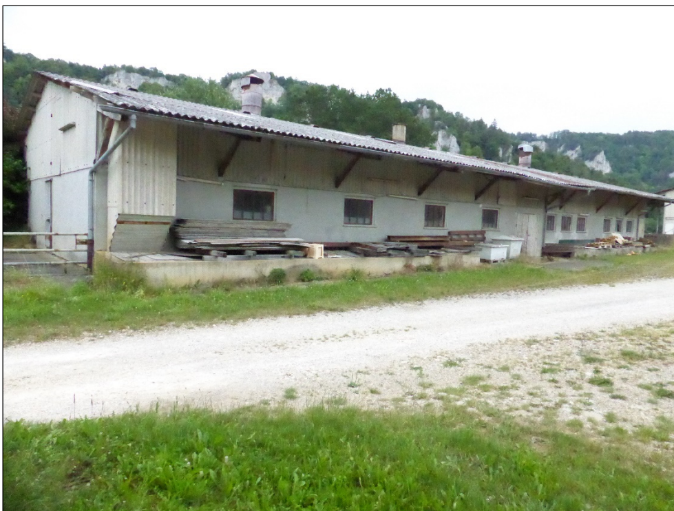
Abb. 12: Ansicht von Gebäude 2 vom Fahrweg aus.
