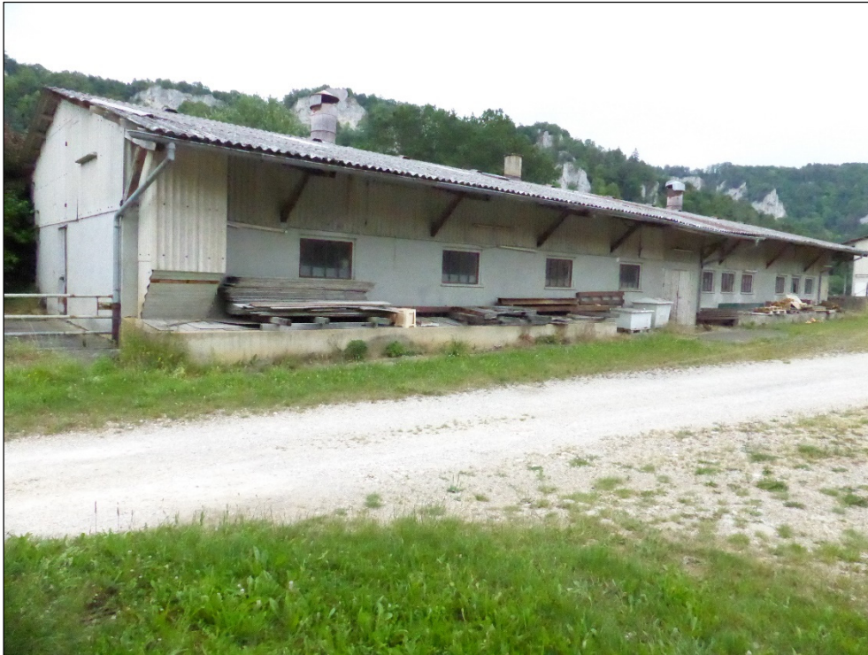
Abb. 10: Ansicht von Gebäude 2 vom Fahrweg aus.
