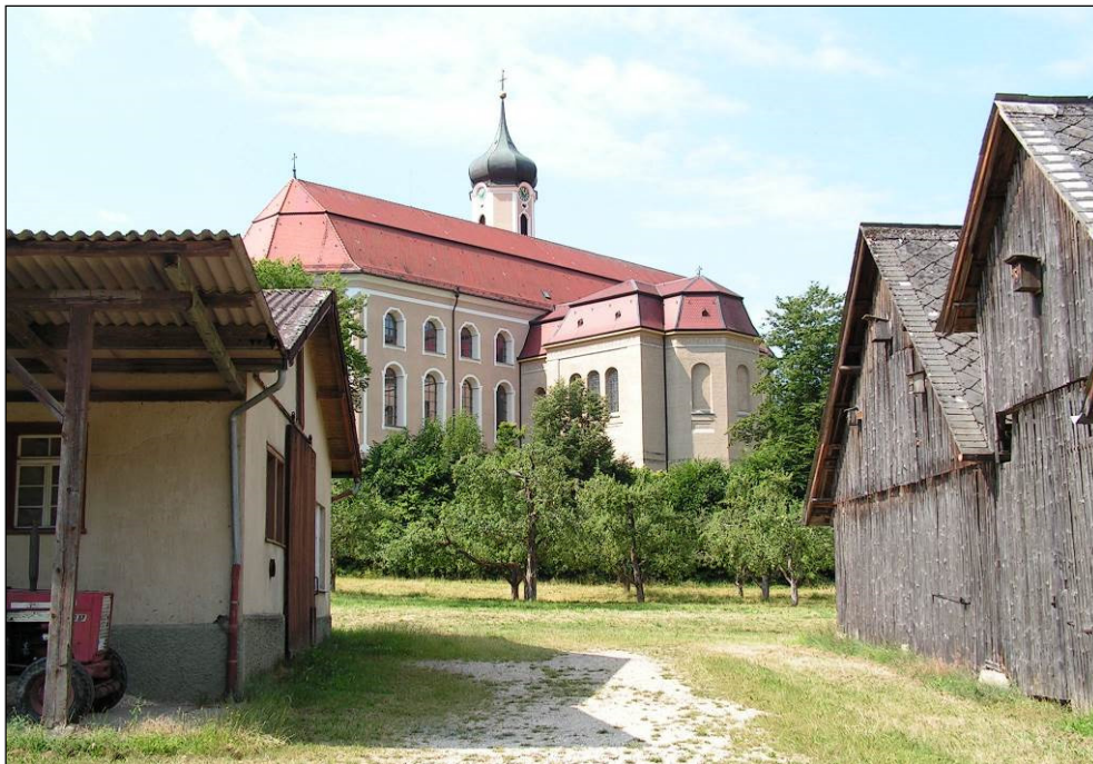
Abb. 18: Blick auf die Klosterkirche zwischen Schuppen und ehem. Stall hindurch (22.07.2020)
