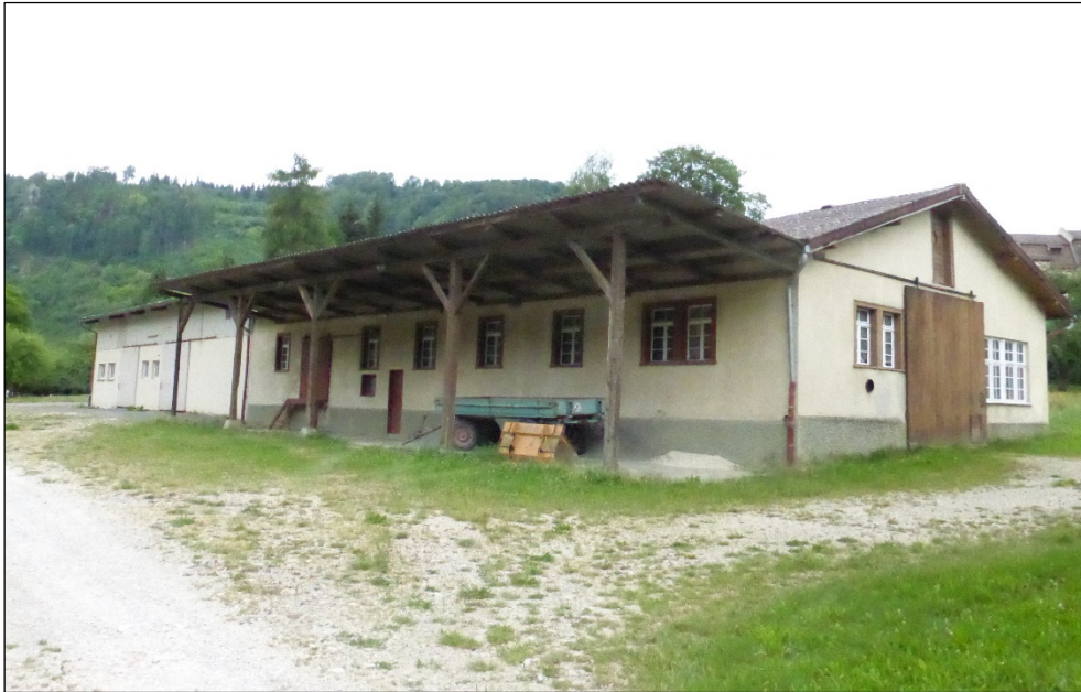
Abb. 11: Ansicht von Gebäude 3 vom Fahrweg aus
