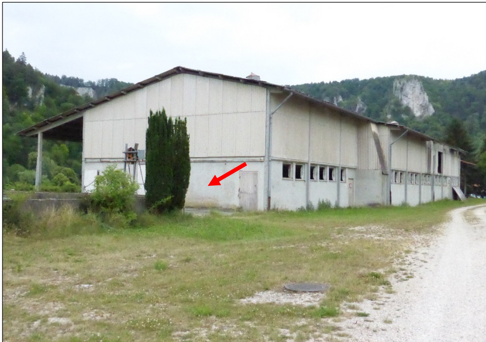
Abb. 12: Ansicht von Gebäude Nr. 4 vom Fahrweg aus. Der rote Pfeil zeigt auf die Türe, in der sich ein Quartier der Zwergfledermaus befindet.
