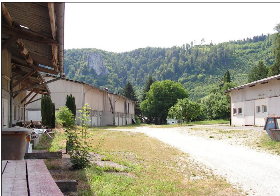
Abb. 2: Die teilweise leerstehenden ehemaligen Wirtschaftsgebäude des Klosters (22.07.2020)
